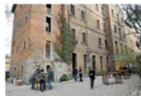
El Konvent, exemple per recuperar les adoberies de Vic arxiu/marta pich
