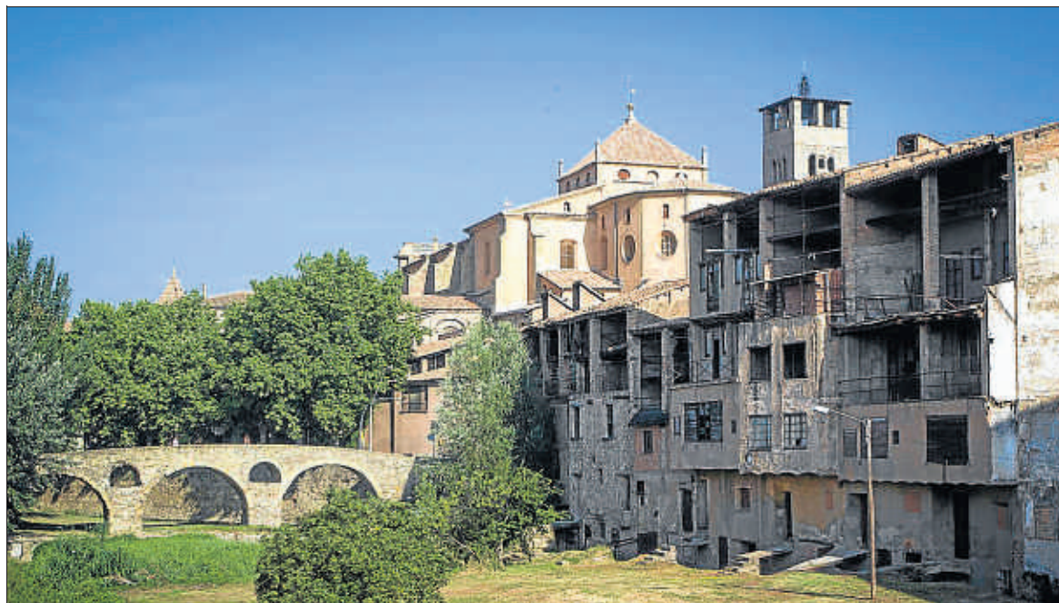
El barrio de las Adoberies de Vic está situado en el margen izquierdo del río Mèder
